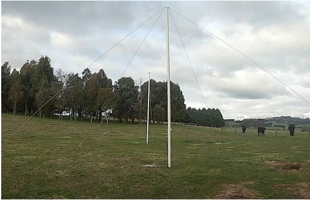
Εικόνα 3: Τα προσωρινά στηρίγματα για τις κεραίες λήψης και εκπομπής σωλήνες PVC διαμέτρου 90mm αγκυρωμένα.
